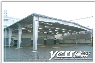
T社社屋建替工事 設計者:自社 完成日:2018年3月 構造・規模:S+RC造・平屋 施工床面積:969㎡+45.86㎡
