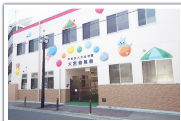
大宮幼稚園改築工事 設計者:ジャクエツ環境事業 完成日:2018年2月 構造・規模:RC造・2F、施工床面積:1,199.52㎡
