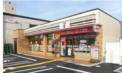
セブンイレブン大阪大宮3丁目店新築工事 設計者：(株)五輪設計
