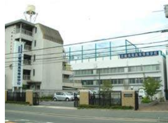
セ近畿情報高等専修学校 大規模改修工事 設計施工：(株)森長工務店
