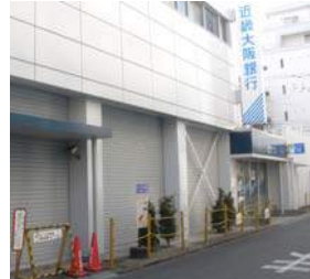
近畿大阪銀行 藤井寺支店耐震補強工事 監修：阪急コンストラクション・マネジメント
