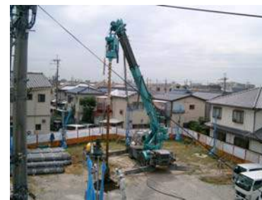
武庫の里(ハート)ガーデン・グループホームときとも新築工事 設計者：中川一級建築士事務所 完成予定：2012年1月 構造・規模：S造・2F・640㎡
