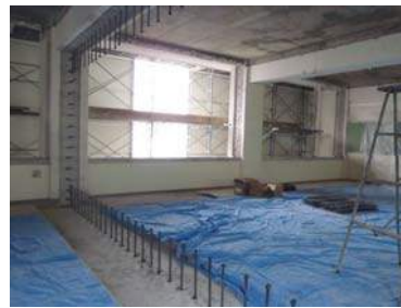
川西市立多田中学校北校舎・屋内運動場棟耐震補強等工事 設計者：㈱三建構造 完成予定：2012年3月
