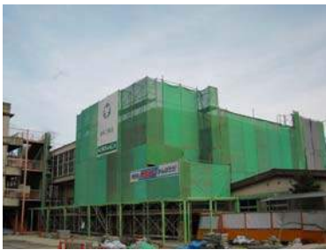
八雲中学校屋内運動場耐震補強工事 設計者：㈱ART建築設計事務所 完成予定：2012年11月 構造・規模：RC造・3F・1282㎡
