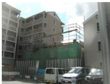
(仮称)元町マンション新築工事 設計施工：㈱森長工務店 完成予定：2012年1月 構造・規模：RC造・5F
