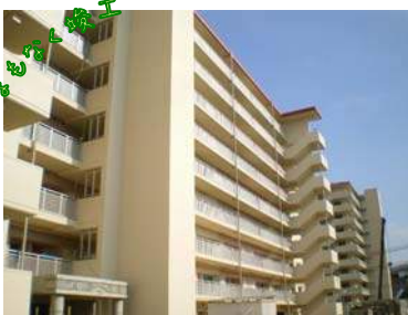
八幡屋宝町第3住宅1号館建設工事 設計者：藤小林総合計画 完成予定：2011年10月 構造・規模：RC造・9F・5357㎡
