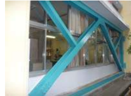
耐震ブレース施工後
