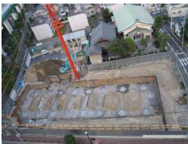
今市住宅1号館建設工事 設計者：㈱板垣建築事務所 完成予定：2012年12月 構造・規模：RC造・12F・6477㎡
