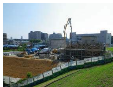
守口市浄水場 薬品注入施設建設および造成工事 設計者：日本上下水道設計院 完成予定：2012年3月 構造・規模：RC造・1F・392㎡
