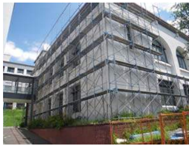
摂南大学枚方学舎1・2号館外壁等改修工事 設計者：学校法人常翔学園 施設課 完成予定：2011年11月 構造・規模：SRC造・2F・14557㎡
