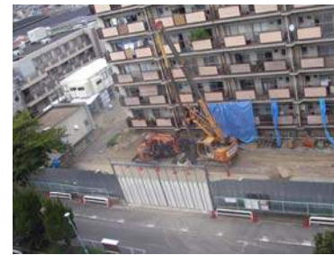
大阪府守口市錦通住宅耐震改修工事 設計者：大阪府住宅まちづくり部公共建築室 完成予定：2013年8月 構造・規模：RC造・8F・㎡
