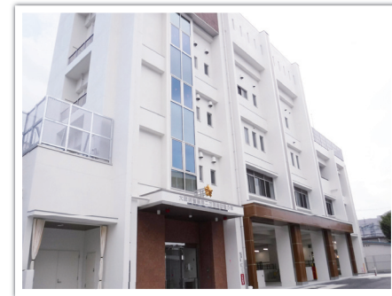
大阪府警察第二方面機動警ら隊新築工事 設計者: 壇建築計画事務所 完成日: 2018年8月31日 構造・規模: RC造・4F、施工床面積: 1,998.30㎡
